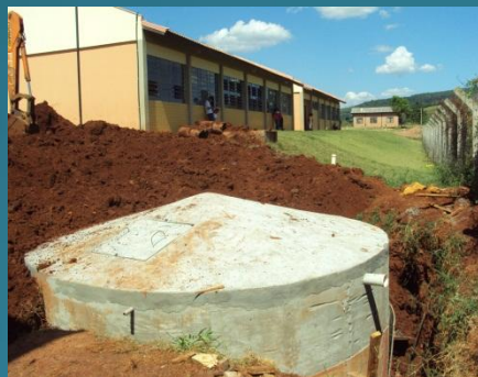
Centro de Artesanato em construção
