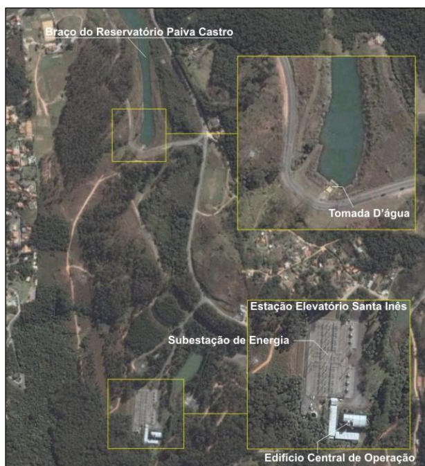
Estação Elevatória Santa Inês e tomada d'água no reservatório Paiva Castro.
