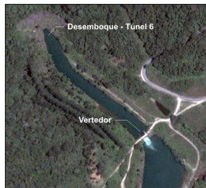
Desemboque do Túnel 6.
