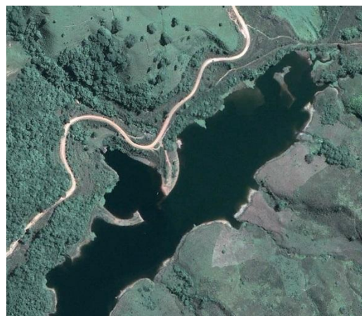
Desemboque do Túnel 7.
