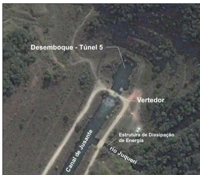
Desemboque do Túnel 5, vertedor e confluência das águas transpostas com o rio Juqueri.
