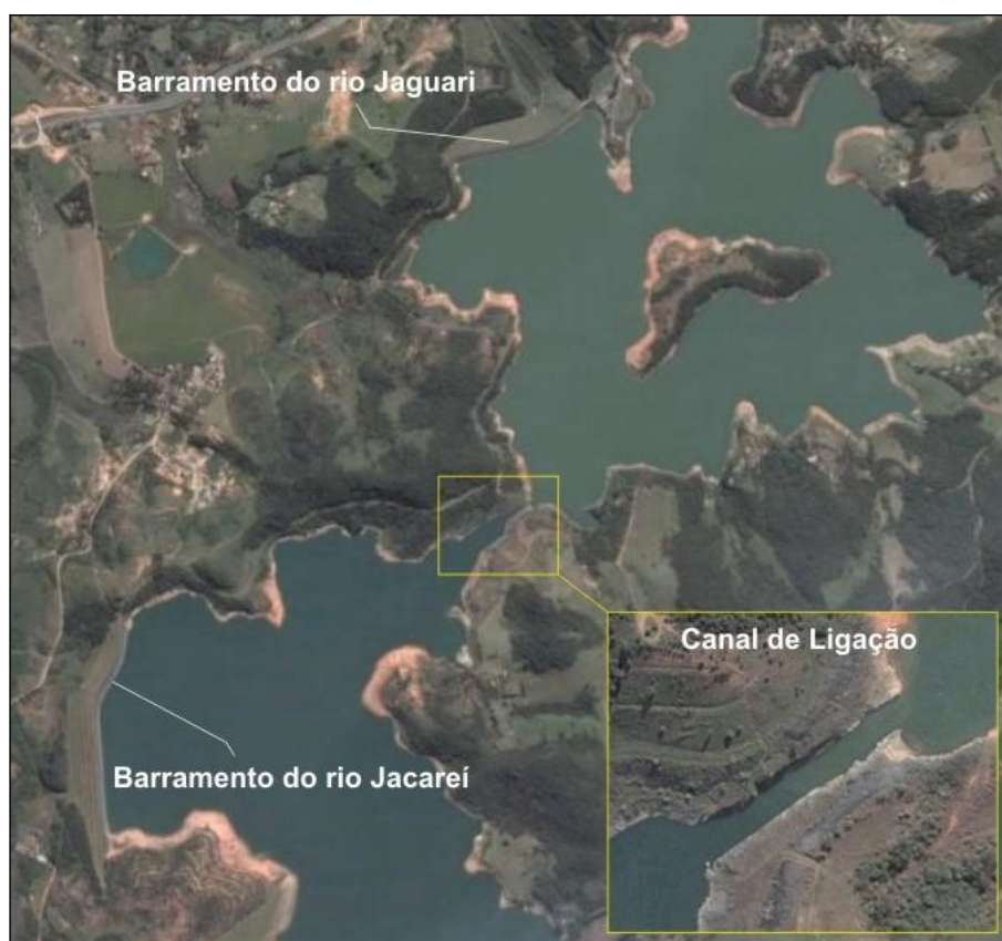
Barragens dos rios Jaguari e Jacareí. Detalhe do canal superficial que faz a ligação entre os reservatórios.
